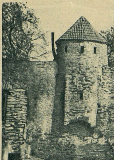
ENSV Tallinn. Linnamüür torniga ЭССР Таллин. Крепостная башня
