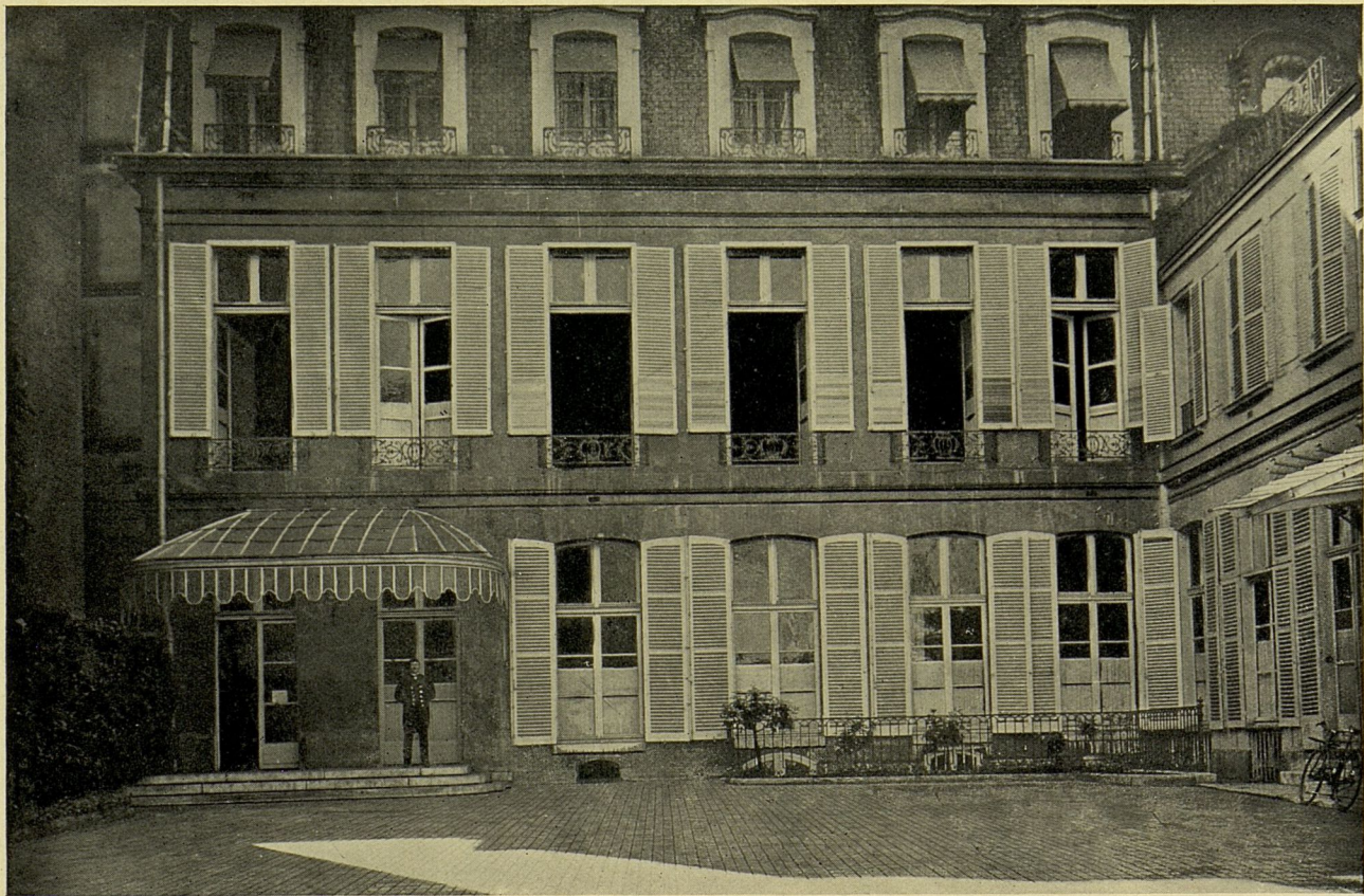
FAÇADE DE L'HOTEL.
